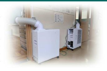
下に排出されてしまいますので、ダクトのような物を取り付けて、廃熱を窓の外に直接逃がすことはできないか考えているところです。
